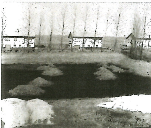
Stavba tenisových kurtů 1975-76
