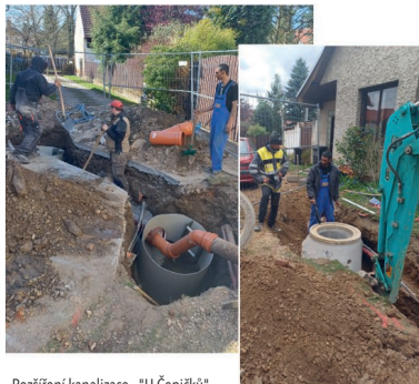
Rozšíření kanalizace - "U Čepičků"
