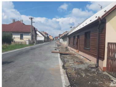
Výstavba chodníku ul. Bechyňská
