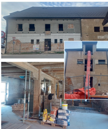
Rekonstrukce domu čp. 75 Malšice
