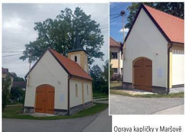
Oprava kapličky v Maršově
