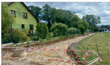
Oprava komunikace k čp.19
