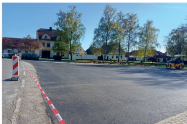
Oprava místních komunikací v Malšicích
