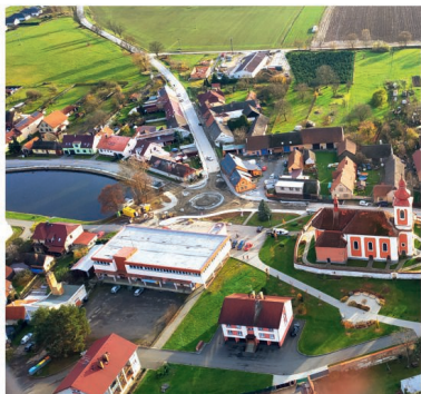
Pohled na výstavbu okružní křižovatky Malšice
