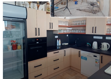
Rekonstrukce "výčepu" a nová fasáda v hospůdce v Třebelicích
