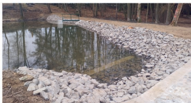
Oprava rybníku ve Všechných p.č. 304/1 - dokončeno v r.2025
