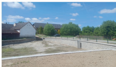
Oprava rybníku v Dobřejicích
