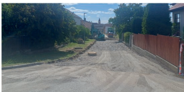
Probíhající asfaltování ulice za školou
