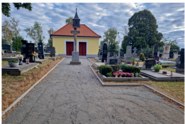
Probíhající stavba zpevněné plochy v Maršově na hřbitově
