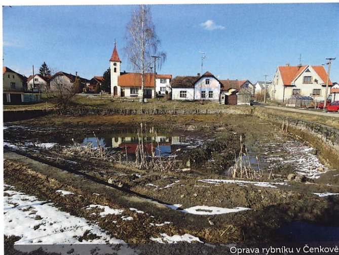
Oprava rybníku v Čenkově
