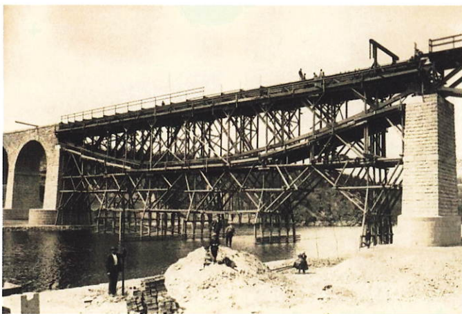
Stavba železničního mostu přes řeku Lužnici v Táboře pro trať Tábor-Bechyně. Rok 1902, foto Šechtla a Voseček. Historické snímky publikovány s laskavým souhlasem Digitálního archivu Šechtla a Voseček.
