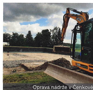
Oprava nádrže v Čenkově
