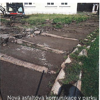
Nová asfaltová komunikace v parku
