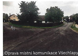
Oprava místní komunikace Všechlapy
