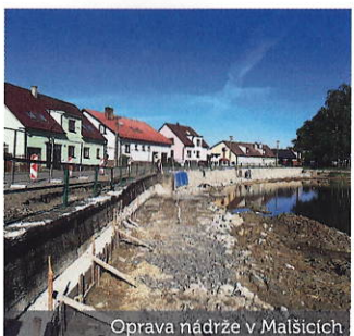
Oprava nádrže v Malších
