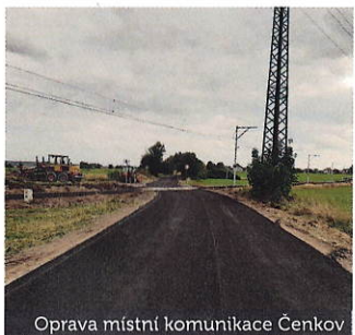
Oprava místní komunikace Čenkov
