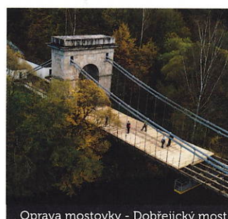
Oprava mostovky - Dobřejický most
