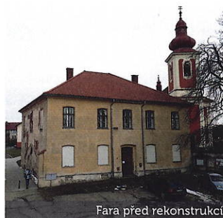
Fara před rekonstrukcí
