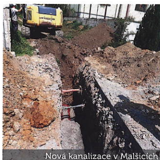
Nová kanalizace v Malšicích
