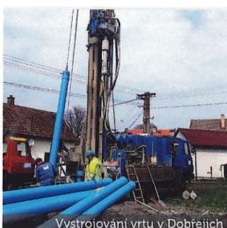
Vystrojování vrtu v Dobřejicích
