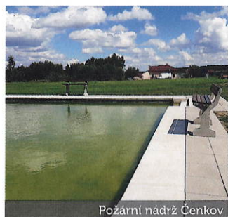
Pozární nádrž Čenkov
