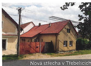
Nová střecha v Třebelicích
