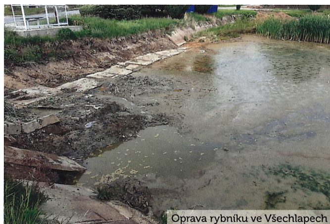
Oprava rybníku ve Všeclapech
