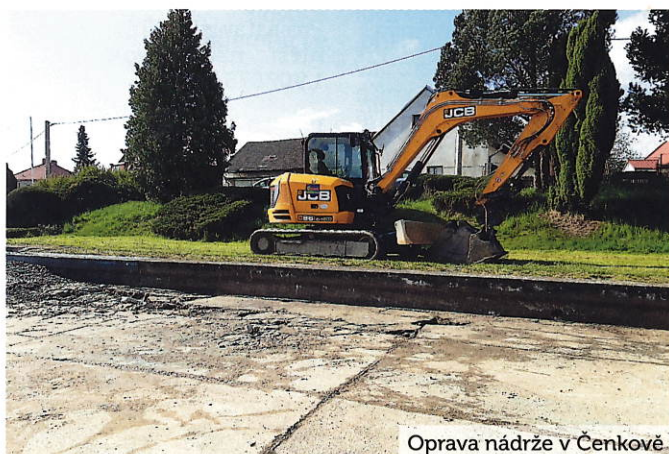
Oprava nádrže v Čenkově
